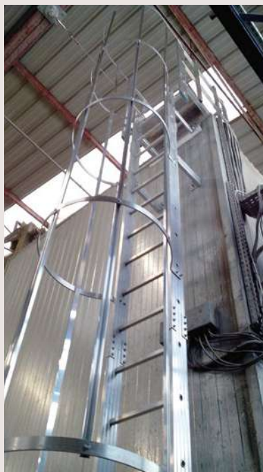
Échelle à crinoline avec montants renforcés 115 x 25 mm
