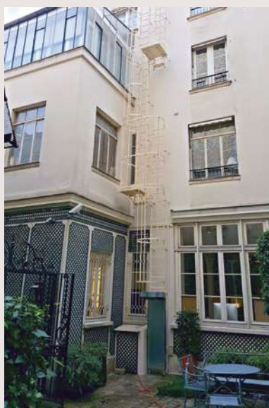
Échelle à crinoline sur immeuble
