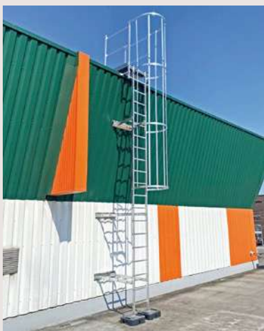
Échelles à crinoline avec fixation sur bardage
