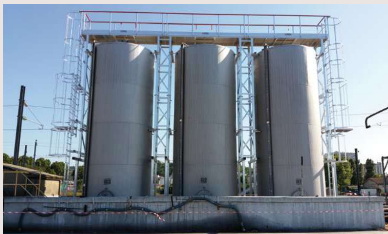
Échelles à crinoline avec passerelle sur silos pétrochimiques
