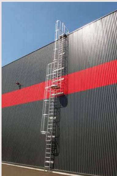
Crinoline sur bâtiment industriel
